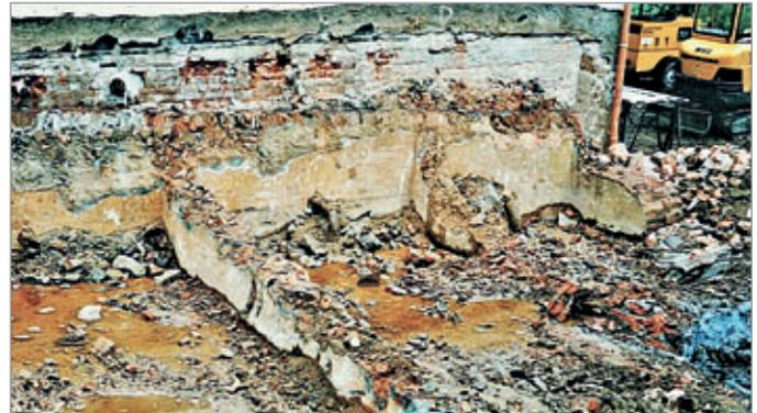
sehen, rechte, nur 2 m breite Kammer. Sie war am werksseitigen Ende mit einem größeren Zugang in den Maßen von etwa 1,75 m mal 0,75 m versehen, welcher mit einem Blechdeckel verschlossen und durch ein Vorhängeschloss gesichert war. Zur Funktion dieses Schachtes wird in Teil 15 berichtet.
