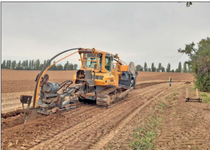
Die bereits gebauten Außerortsverbindungen wurden zum größten Teil mit einem Kabelpflug realisiert, hier zwischen Altlommatzsch und Scheerau. | Foto: ENSO NETZ
